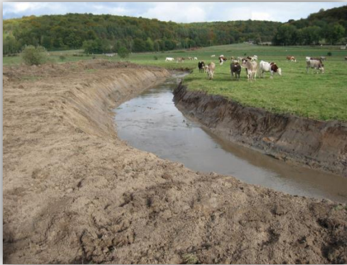
Travaux de renaturation de la Digeanne à Essarois (21)
