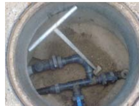
Le regard de transfert des eaux de pluies ou de l'eau du forage
