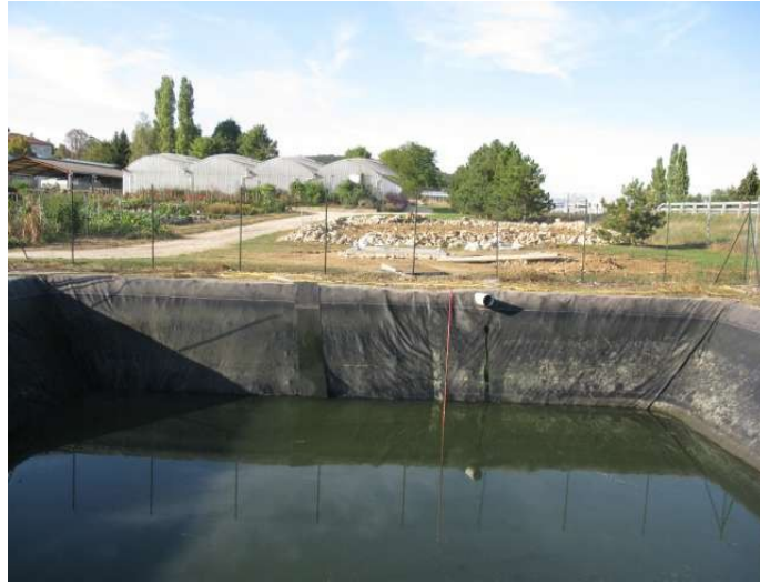
Bassin de récupération des eaux de pluies et des eaux d'arrosage
