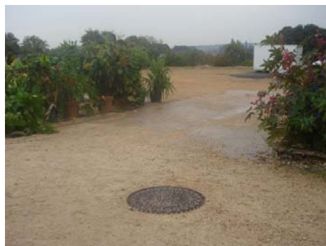
Le regard de transfert des eaux de pluies ou de l'eau du forage
