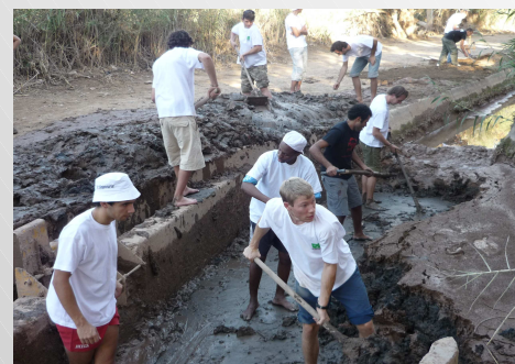
La restauration du canal débute
