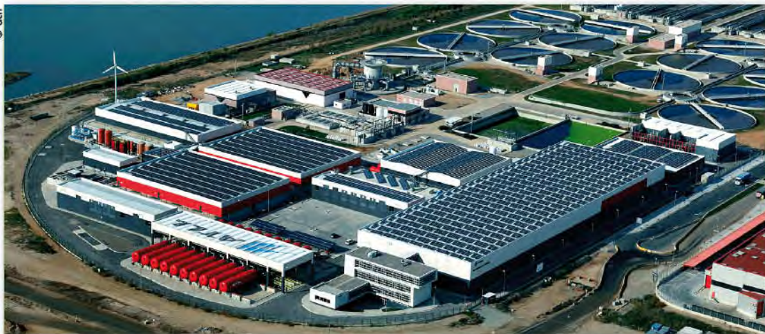
Ouverte en 2009, l'usine de désalinisation de Llobregat permet une autosuffisance en eau de la région.
