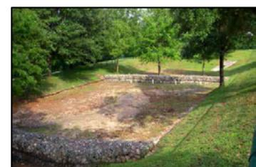
Figure 15 : Filtre à sable de surface
