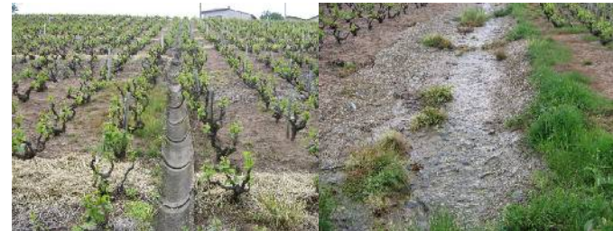
10 Demi-buses et chenal ouvert bétonné
