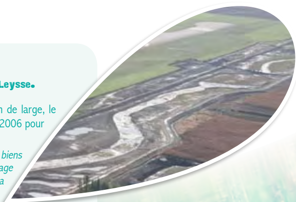
Tracé du bras de décharge lors de son terrassement - 2006
