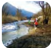
Réalisation du bras d'alimentation de la lône.
