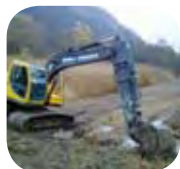
Terrassements dans la roselière : décapage superficiel et creusement du bras d'alimentation.
