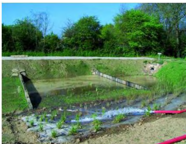
Figure 9: Vue du bassin d'orage de Cérizay
