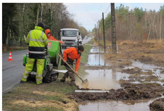
Photo 18 - Travaux de restauration hydrologique visant à limiter l'impact de la route départementale qui traverse la tourbière de la Guette [18] (© F. Laggoun-Defarge)
