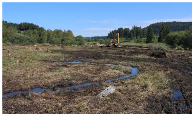
Photo 21 - Travaux de restauration du fonctionnement hydrologique du marais du Châtelet (Saint-Laurent-en-Grandvaux, 39). Le reméandrement de la Lemme permet d'améliorer l'alimentation en eau de cette tourbière (© F. Muller)
