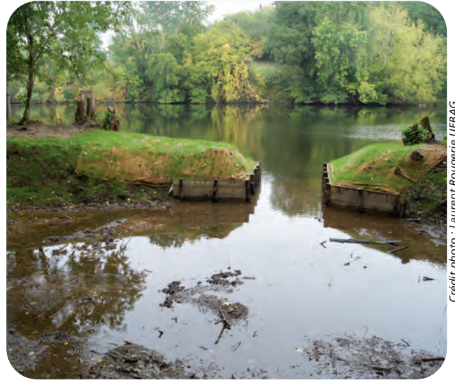
Reconnexion hydraulique et stabilisation de berges sur les sites des Bouysses dans le Lot (46).
