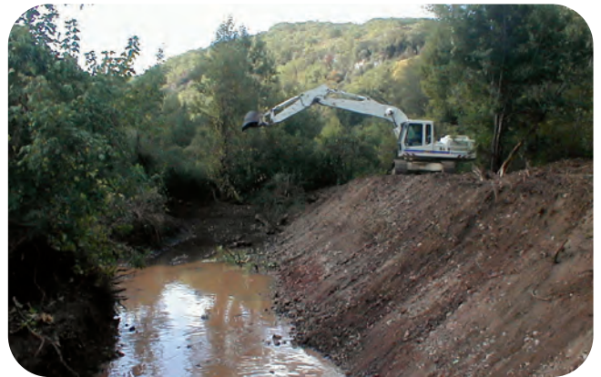
Reprofilage d'un bras mort à Cajarc dans le Lot (46).
