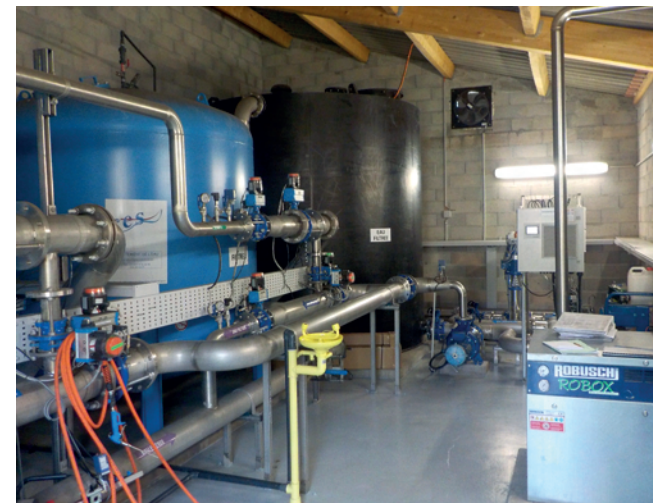
Traitement tertiaire pour une capacité maximale de 200 m 3 /j en qualité A Exploitation en régie : de l'ordre de 5 h par semaine en période d'irrigation (hors analyses) Investissement initial de 410 000 € HT [ données SIVOM du Littoral des Maures ]
