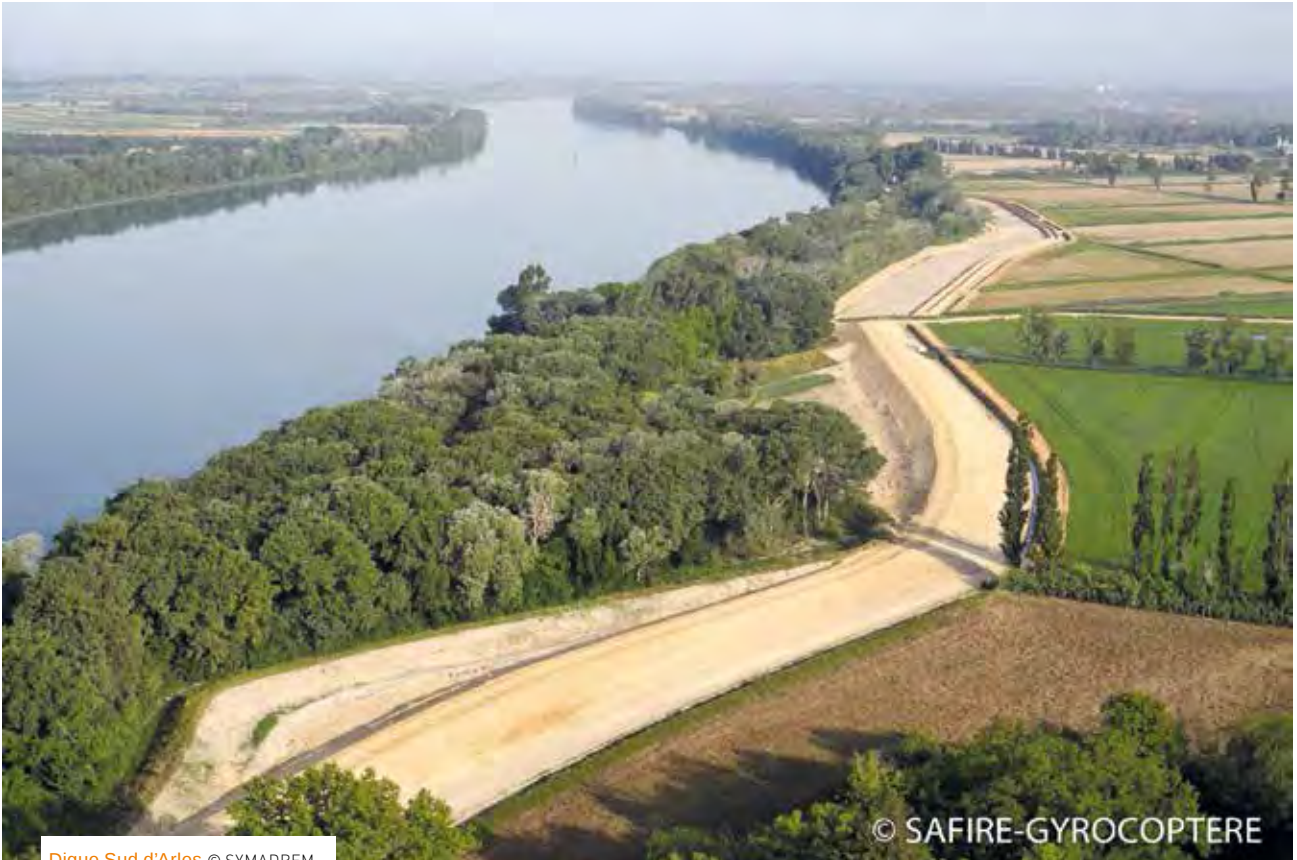
Digue Sud d'Arles © SYMADREM
