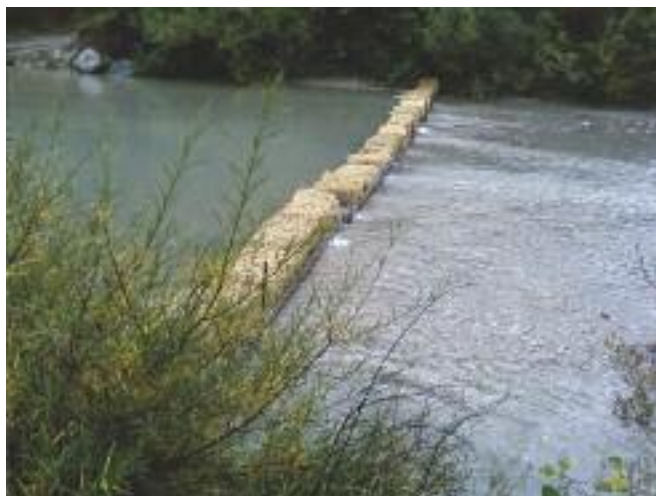
Balles de paille en travers d'un cours d'eau
