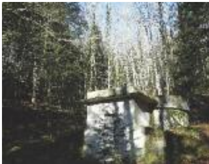
Captage de source
