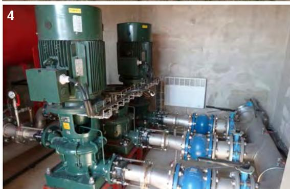
1) La station d'épuration. 2) La lagune de traitement tertiaire et de stockage des eaux usées traitées. Arrivée d'eau épurée à l'extrémité opposée du bassin. Le 3 août 2015 : niveau d'eau bas à 1,78 m (4 m en début de saison d'irrigation). 3) Station de pompage au pied de la lagune. 4) Équipement de la station de pompage : 3 pompes pour la mise en pression du réseau irrigation.
