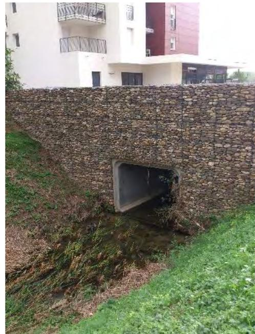
Figure 10 : Aménagement de l'écoulement au niveau d'un mur
