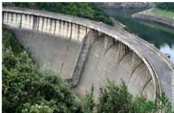
Barrage écrêteur de crues et soutien d'étiage de Sénéchas, situé sur la rivière « la Cèze », affluent du Rhône (30)
