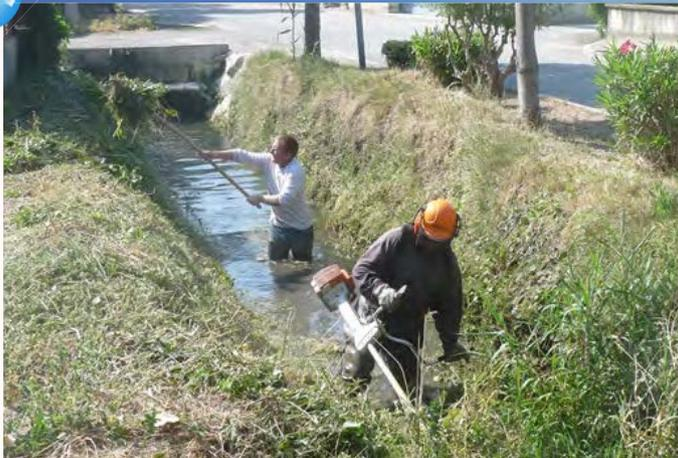
Les fossés sont des ouvrages artificiels destinés à l'écoulement des eaux voire à la délimitation des terrains. Bien que nécessitant d'être entretenus, ils ne sont pas soumis à procédure loi eau.
