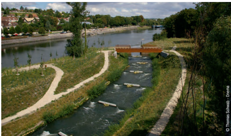
Rivière artificielle de contournement du barrage d'Andrésy.
