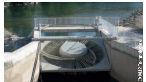
Turbine ichtyocompatible à basse chute VLH.
