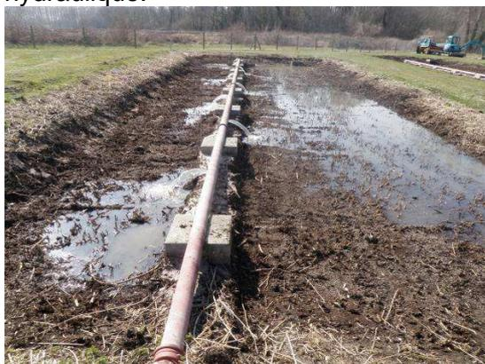
Figure 12 Remise en eau du filtre après curage et flaquage provisoire (Gensac La Pallue (16))
