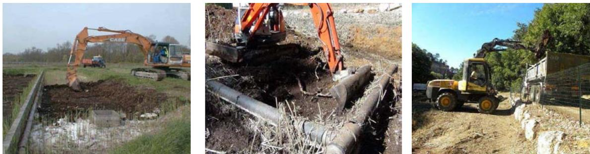
*Figure 10 A gauche : Curage depuis le bord par une pelleteuse à longue flèche (Gensac La Pallue (16)). Au centre : curage par une mini pelle située dans le filtre (Roussillon (84), crédit photo : ARPE). A droite : reprise des boues curées stockées sur la station, et chargement d'un camion pour le transport (Roussillon (84), crédit photo : ARPE)*
