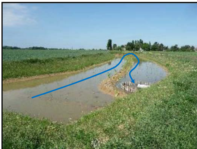
Figure 11 : ZTHA en cours de végétalisation avec une diguette centrale
