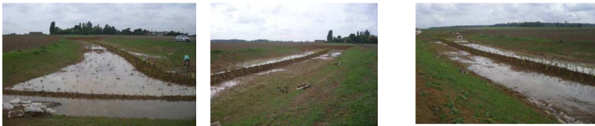
Figure 48 : Travaux de végétalisation de la ZTHA des Vaux (bassin versant de Rampillon)
