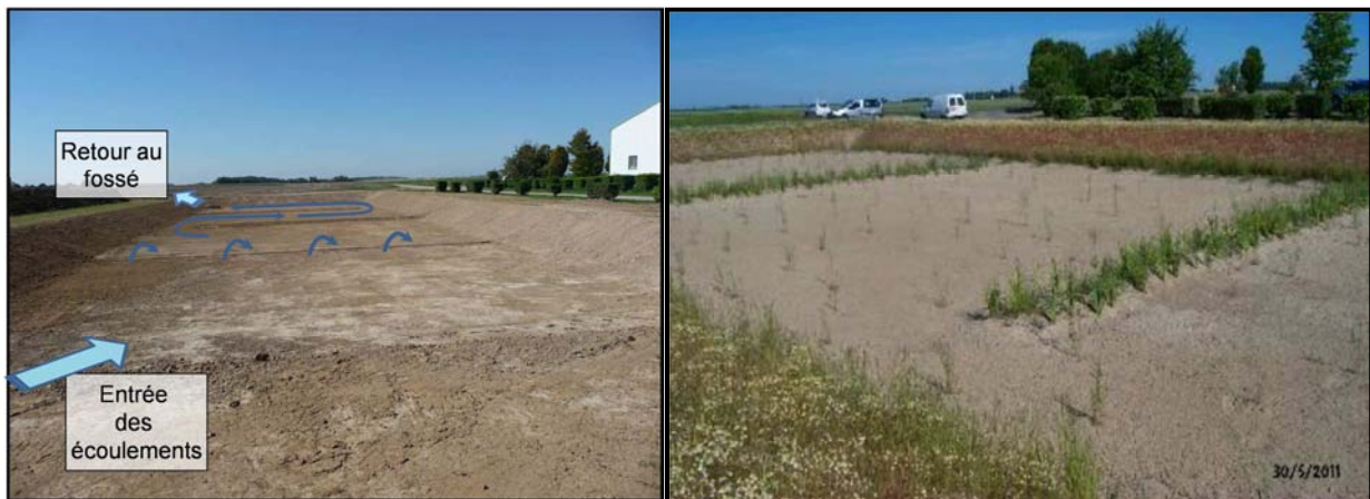
Figure 30 : ZTHA de Montepot avec implantation de chicanes (bassin versant de Rampillon)
