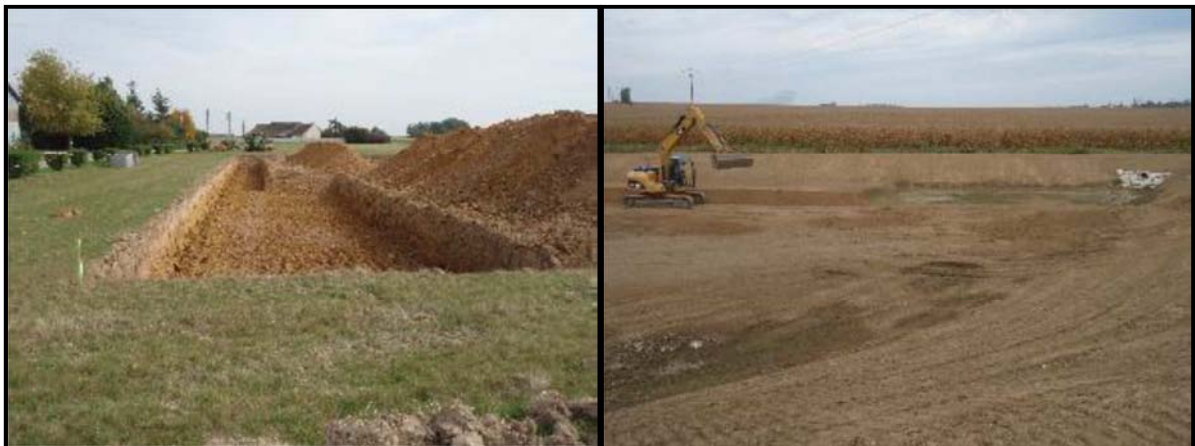
Figure 44 : Terrassement d'un bassin de Rampillon
