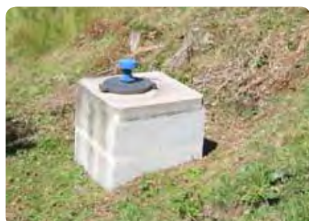
Captage dans le bassin versant de l'Arve (Haute-Savoie)
