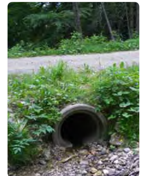
Desserte forestière aménagée en tenant compte des eaux de surface et de la pente
