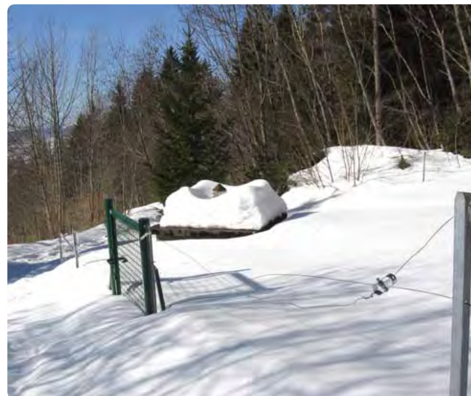
Clôture abîmée par la neige (Haute-Savoie)
