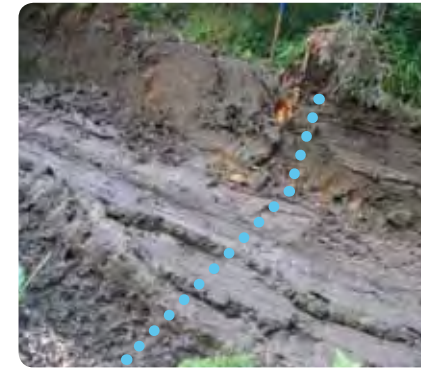
Matérialisation d'une conduite d'eau traversant une piste forestière* : borne bleue (Annemasse)
