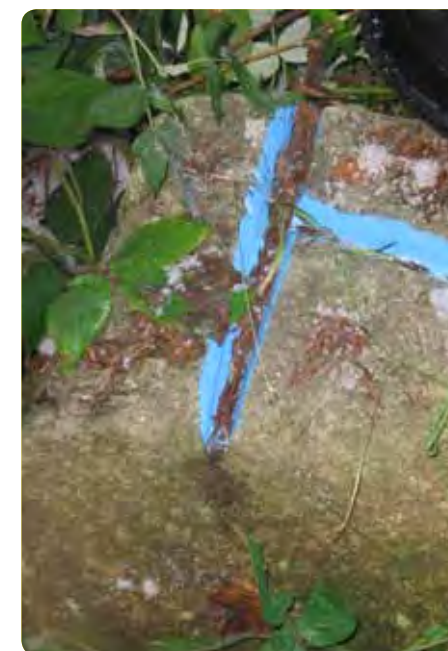
Matérialisation des drains, surveillance
