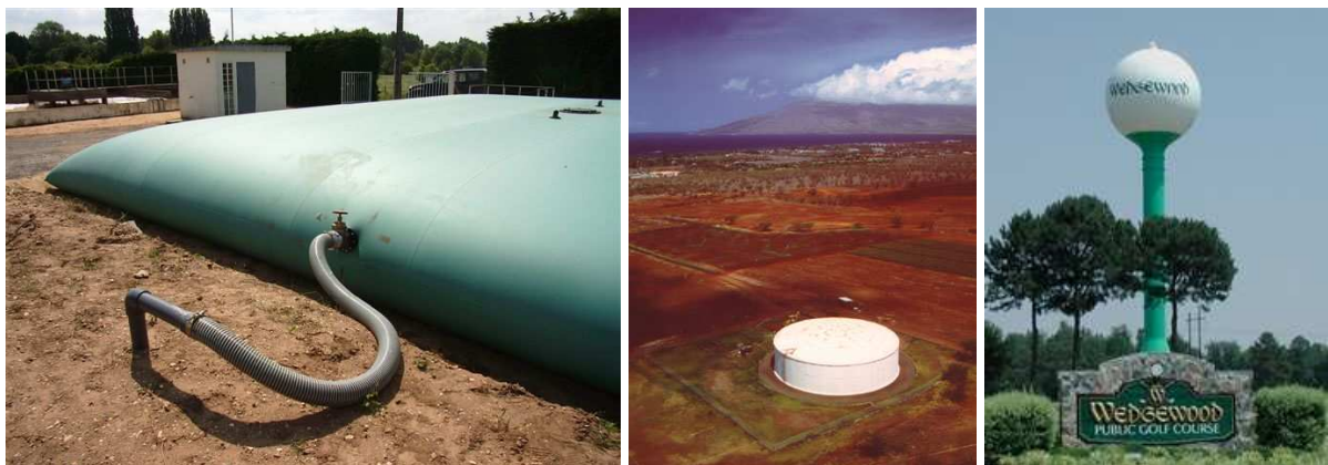
Figure 26 : Réservoirs opérationnels fermés
