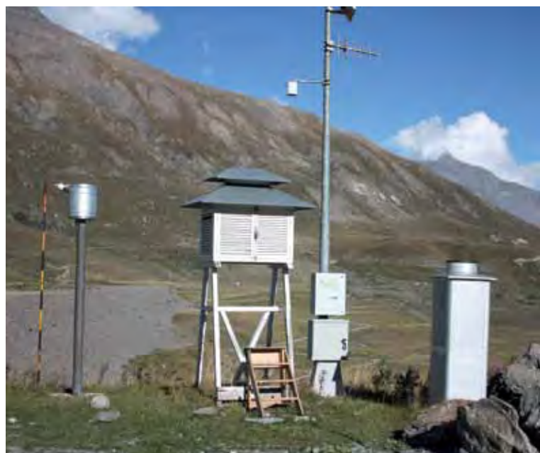
Station météorologique (barrage du Mont-Cenis).
