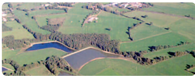
Crédit photo : lycée agricole Montmorillon
