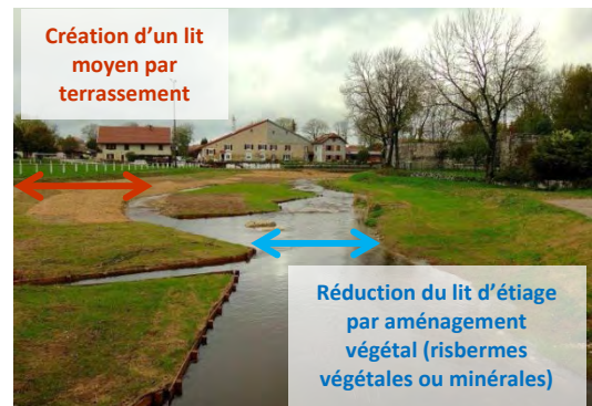
Le principe des lits emboîtés à Bouverans, SMMAH
