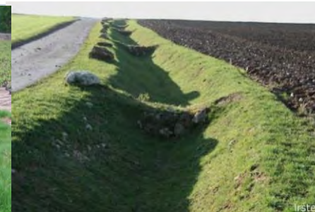
Fossé à redents
