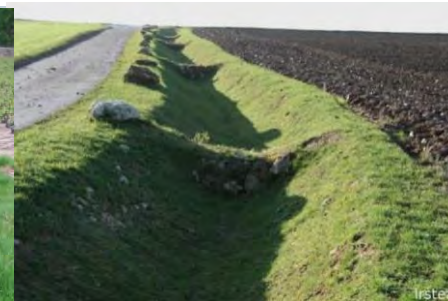
Fossé à redents
