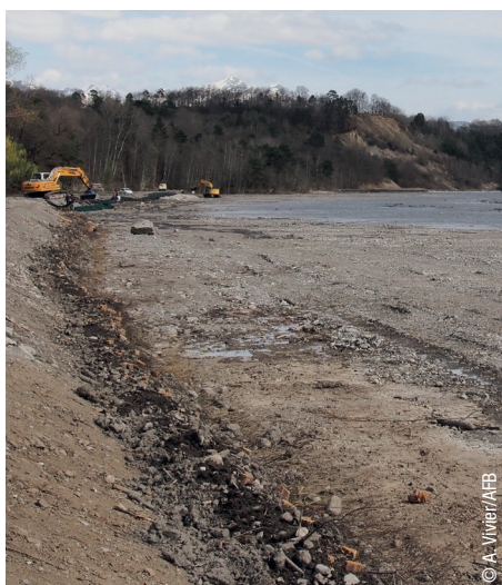
Figure 4. Travaux du Drac (05) en avril 2014.
