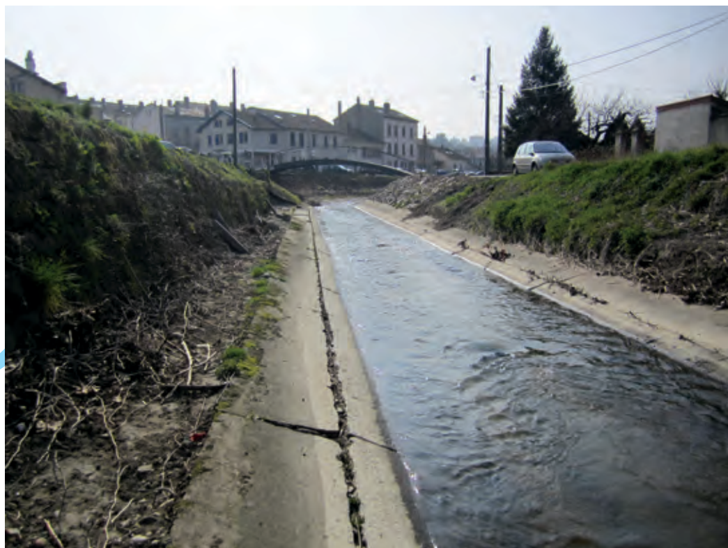
AVANT l'Yzeron canalisée en 2009
