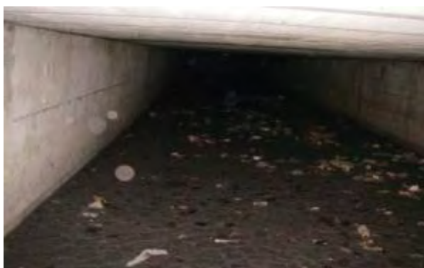
Figure 67 : Bassin enterré – Photo (Communauté Urbaine de Bordeaux, 2014)
