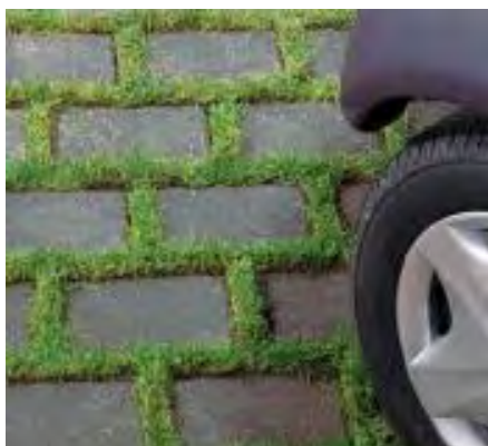
Figure 37 : Pavés à joints larges (Pierreetsol.com)
