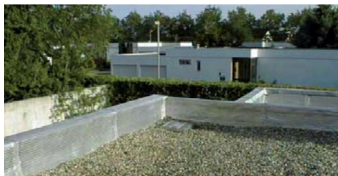
Figure 51 : Toiture-terrasse stockante (Communauté Urbaine du Grand Lyon, 2008)
