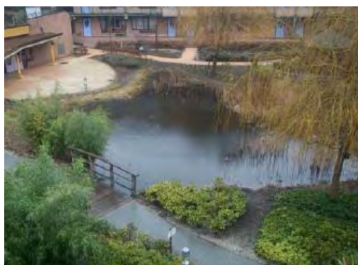
Figure 44 : Marre d'infiltration (Rombaut, 2010)
