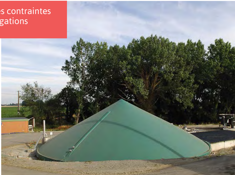
La couverture des fosses à lisier permet de conserver l'azote ammoniacal et d'empêcher les infiltrations d'eau.
