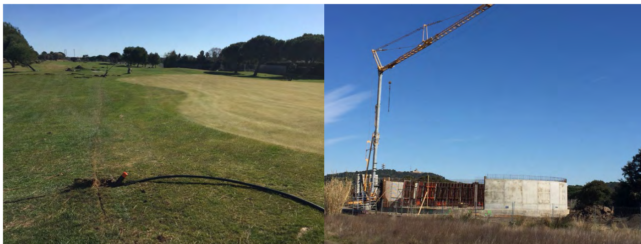
Photos : détails de la solution retenue en termes d'asperseur minimisant les travaux in situ (gauche) & construction du réservoir (droite)
