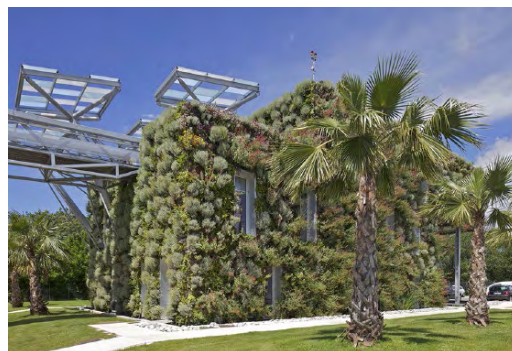
Première station de traitement des eaux usées carbonneutre du monde, Station Aquaviva à Cannes Source : site internet de Suez https://www.suezwaterhandbook.fr
