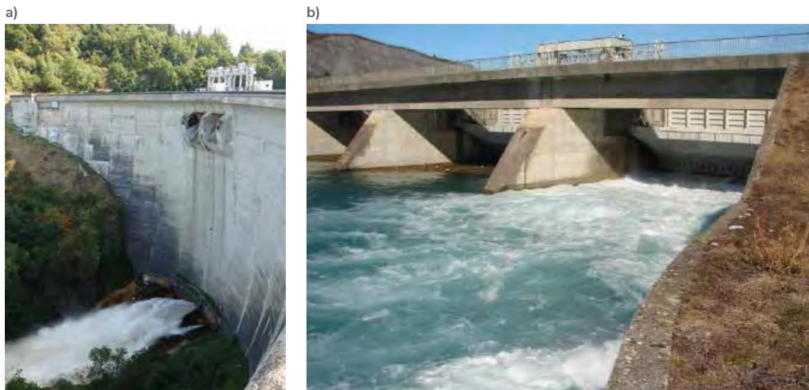
Figure 34. Photographies de deux lâchers morphogènes, a) sur la Selves par une vanne de fond et b) droite sur la Durance par vannes de surface.
