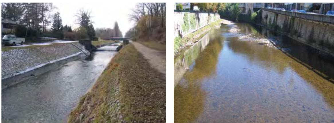
Figure 5. Exemple de rivières chenalisées (ici rectifiées, recalibrées et dont les berges sont protégées).
