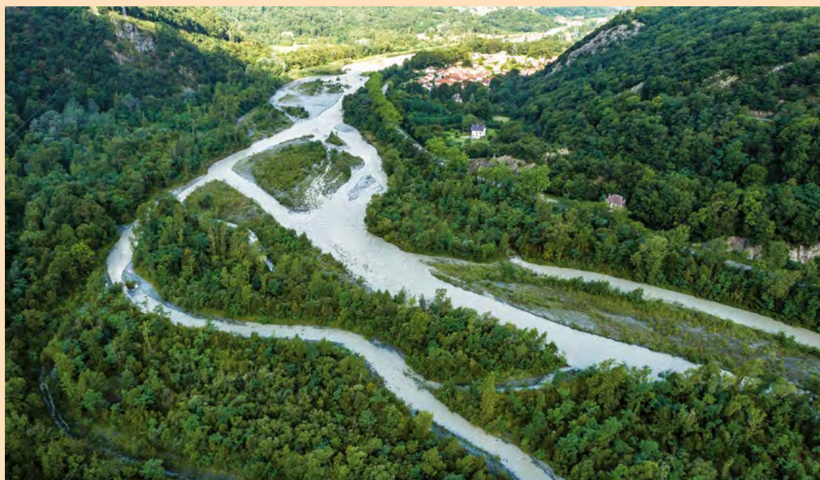
Projet Romanche Séchilienne - Restauration de l'espace de liberté sur le secteur de l'Ile Falcon à Saint Barthélémy de Séchilienne intégrant la réouverture de 1,5 km de bras et la suppression de 250 ml de protection en enrochement. © Symbhi – Dupont Renoux.
