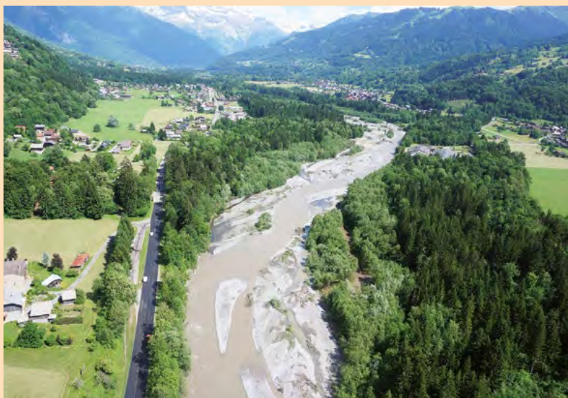
Image aérienne post travaux. © SM3A
