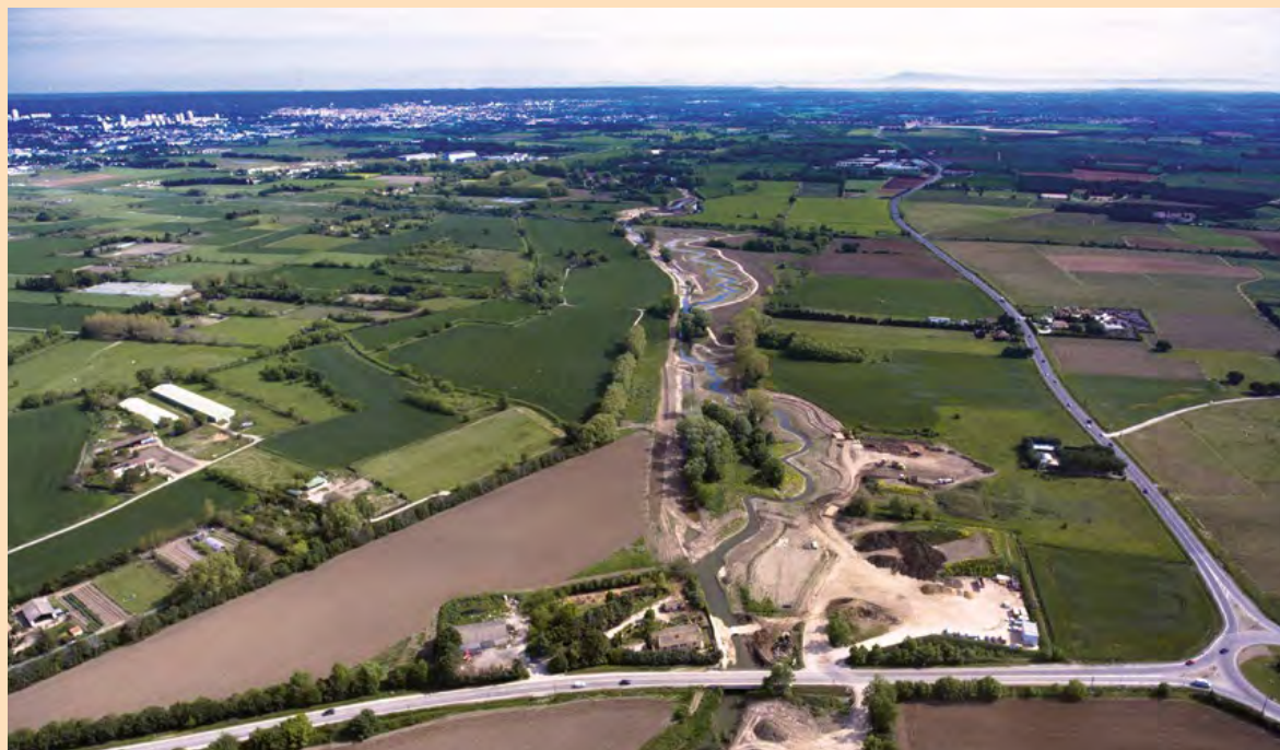
Le Vistre à Milhau après les travaux en 2016. © Agora Communication
