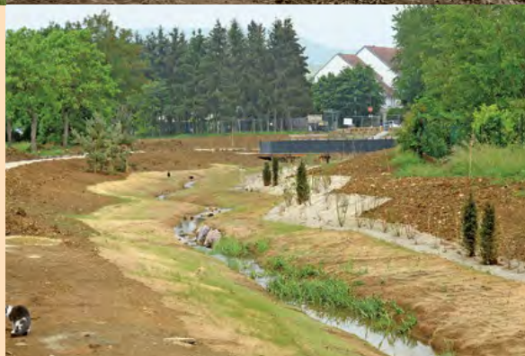
Le ruisseau du Grémillon dans la traversée du parc de Pulnoy (aménagement d'un lit majeur, re-méandrage et renaturation des berges). © MGN (Frédéric MERCENIER).
