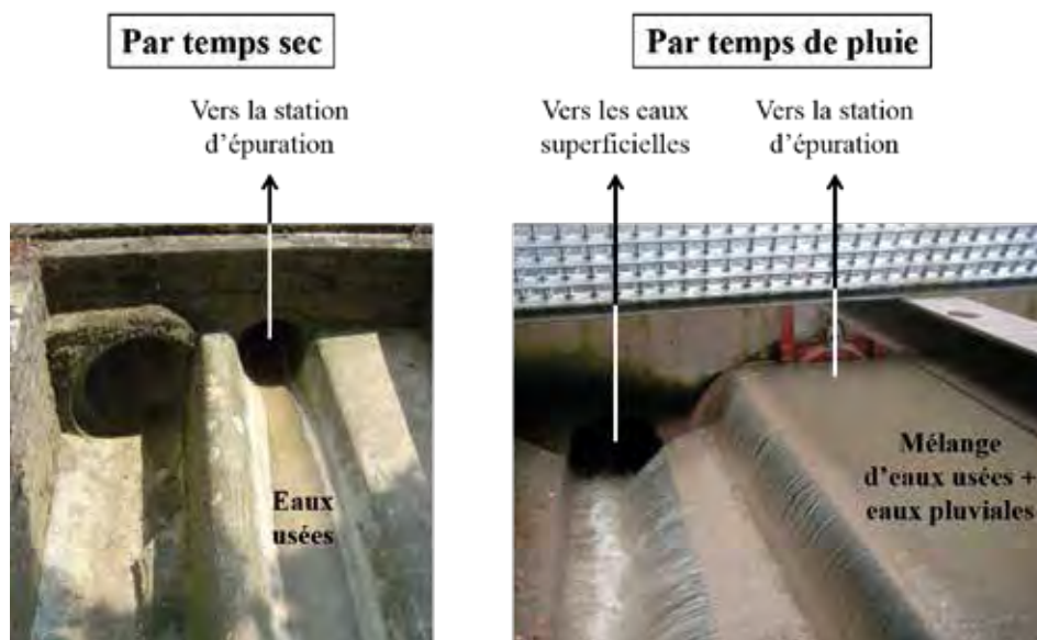
Figure 0.2 – Surverse d'un réseau unitaire (© Gouvernement du Grand-Duché du Luxembourg).
