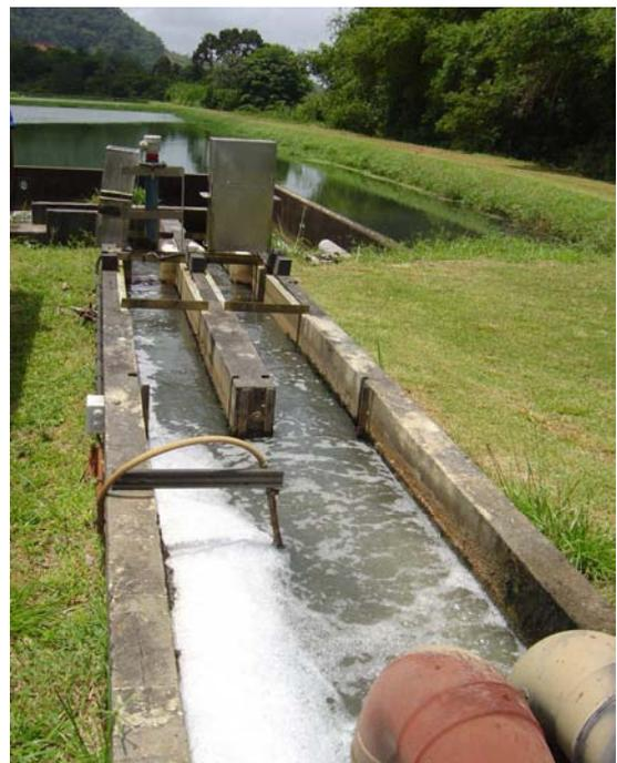
Canal d'alimentation d'une station de lagunage
