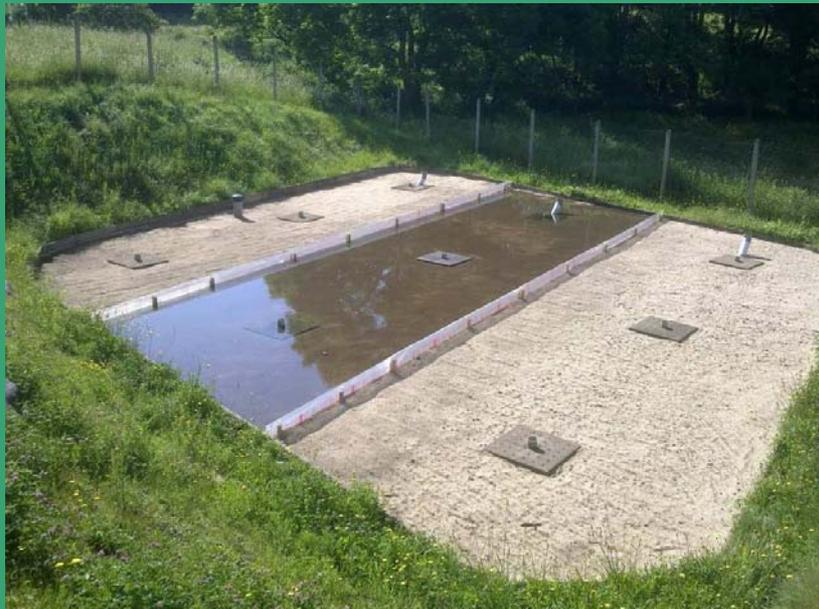
*Bassin d'infiltration-percolation alimenté (section centrale) et scarifié*
