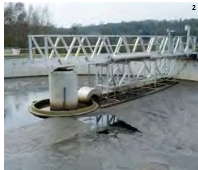
1. Installations de traitement des eaux usées de la station d'épuration de Honfleur 2. Bassin de décantation et de traitement des eaux usées 3. Fosse toutes-eaux dans une installation d'assainissement.
