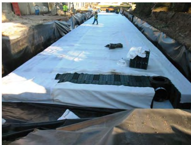
Figure 42 Mise en place de SAUL
