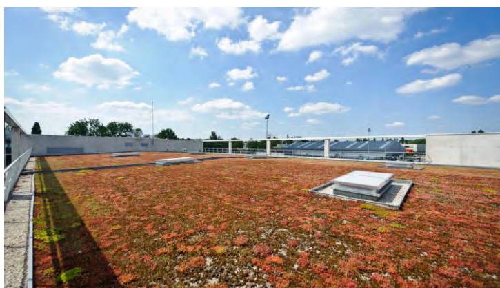
Figure 45 Toiture végétalisée Source : CEREMA 36
