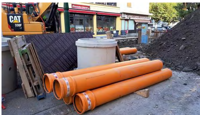
Figure 2 Canalisation gravitaire Source : Montmasson
