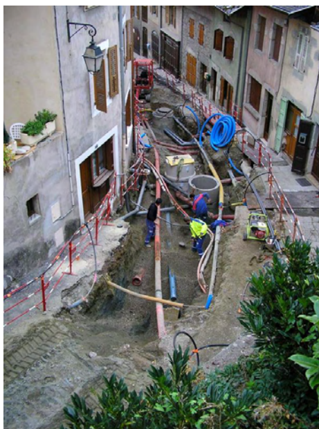
Figure 13 Mise en séparatif par création d'une canalisation à côté de la canalisation unitaire Source : Montmasson
