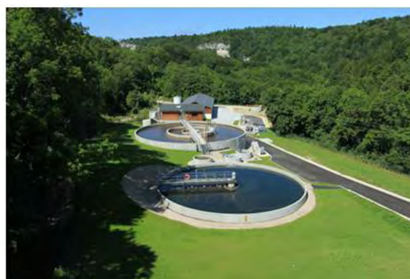
Figure 33 A gauche : réserve de chlorure ferrique pour le traitement physico-chimique du phosphore et à droite : traitement de l'azote par boues activées
