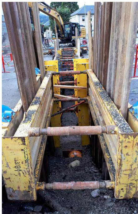
Figure 11 Étanchéification d'un réseau par changement des canalisations en lieu et place Source : Montmasson
