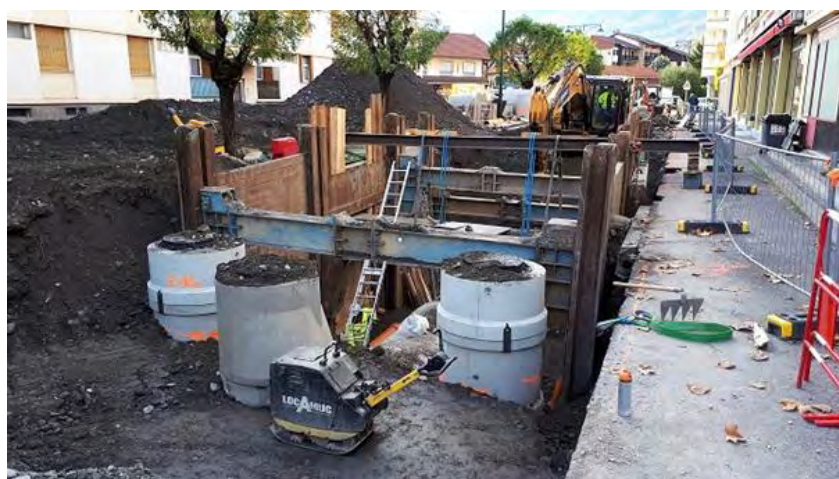
Figure 15 Mise en séparatif par destruction de la canalisation unitaire et création de la canalisation d'eaux usées
