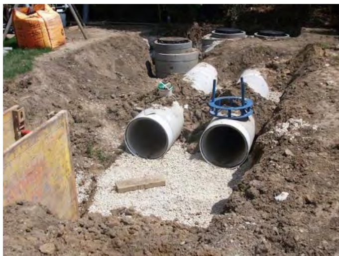
Figure 17 Travaux de mise en séparatif du réseau d'assainissement Source : Cecotech 17
