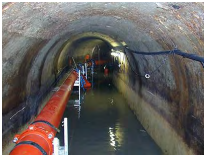
Figure 10 Travaux spéciaux : canalisation d'eaux usées posée dans une galerie souterraine existante d'amenée des eaux
