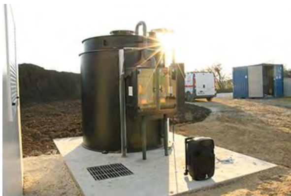
Figure 33 A gauche : réserve de chlorure ferrique pour le traitement physico-chimique du phosphore et à droite : traitement de l'azote par boues activées
