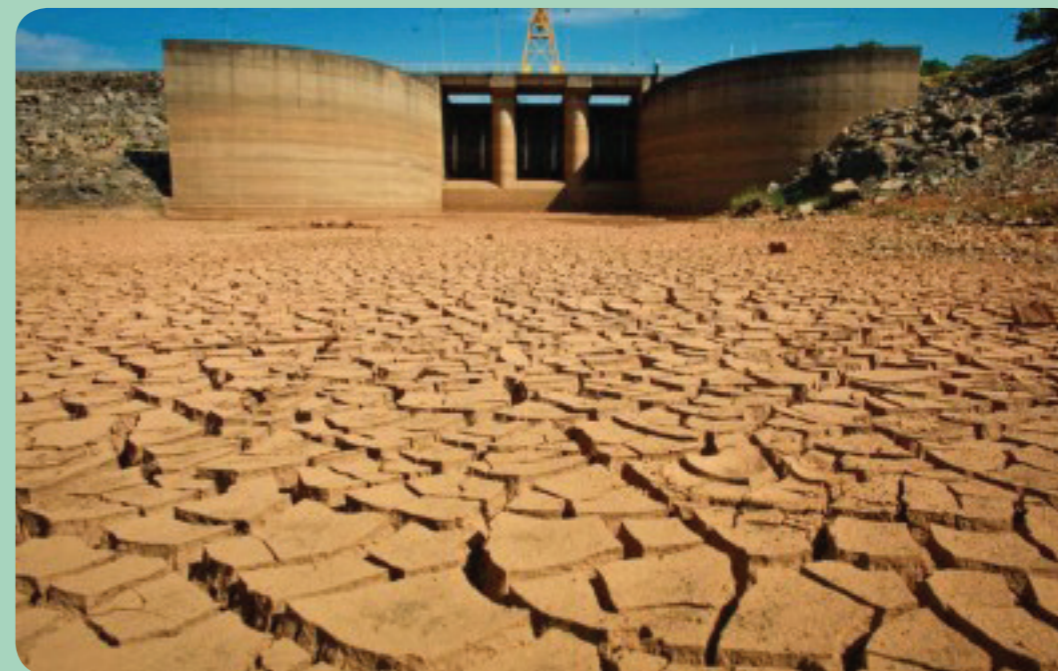
Barrage de Paraibuna, système d'approvisionnement de Cantareira, région de Sao Paulo
