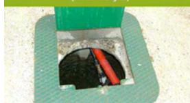
Trappe d'accès à la cuve enterrée de récupération d'eau de pluie des serres municipales (source : Mérignac)
