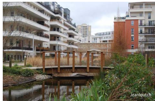
La ZAC Desmoulins à Cachan : au cœur d'un îlot construit se côtoient noues, fossés et bassins paysagers qui récupèrent les eaux de ruissellement des zones imperméables.
