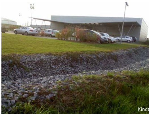
Cette entreprise nordiste infiltre les eaux de pluie de ses surfaces perméables par une noue dont les berges sont maintenues par enrochements.
