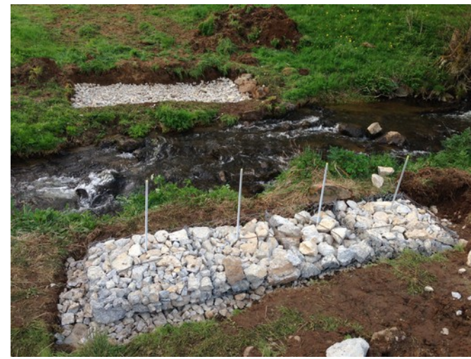
2- Mise en place des fondations (gabions)
