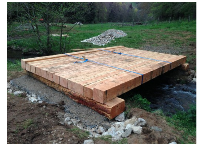
4- Mise en place du tablier
