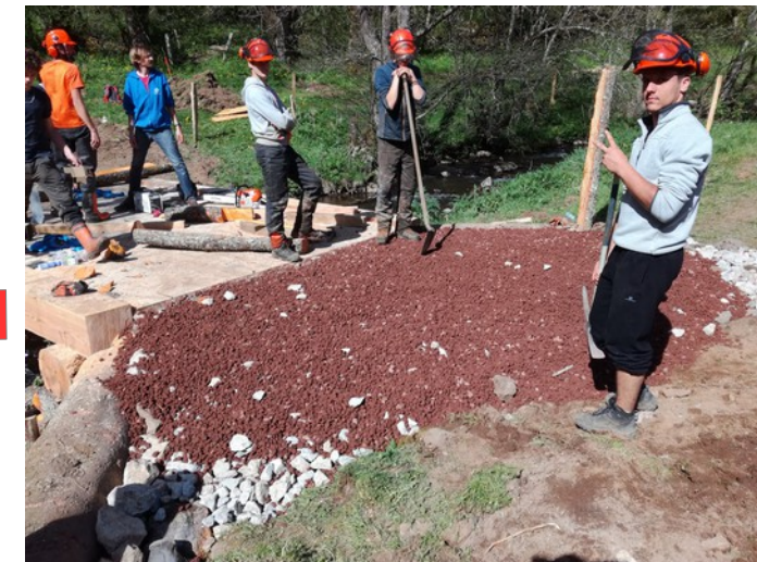
5- Mise à niveau des rampes d'accès
