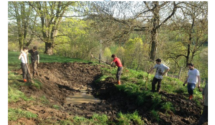
4: Façonnage des berges à la pelle puis à la main
