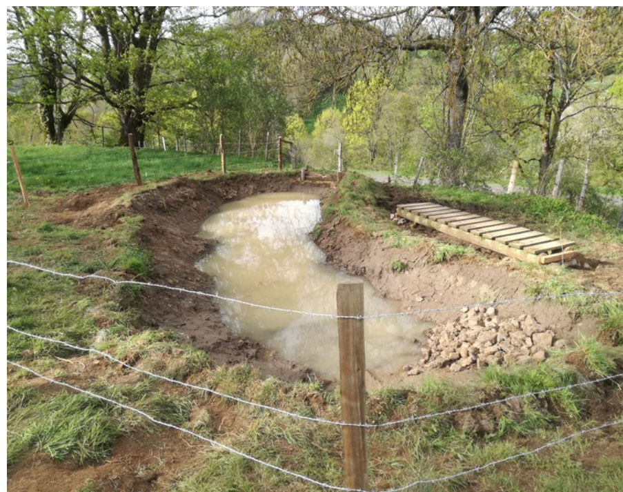
8: Fin des travaux de la nouvelle mare
