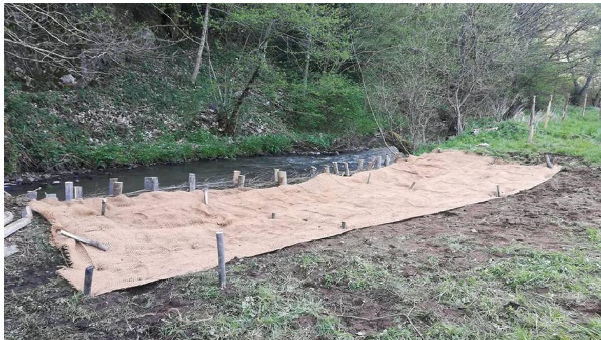
6 : Retaille des pieux et opération terminée !
