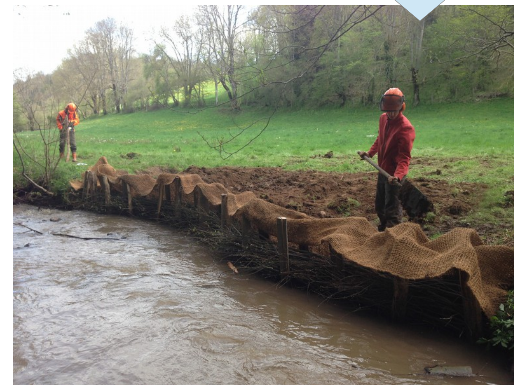
4 : Retalutage de la berge
