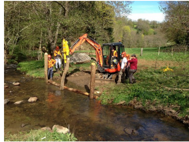
2 : Enfouissement des pieux
