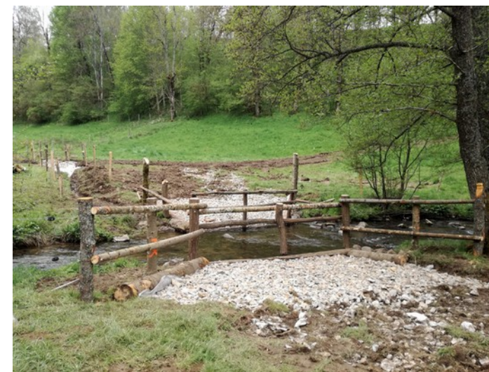
6: « Ossature » en bois terminée
