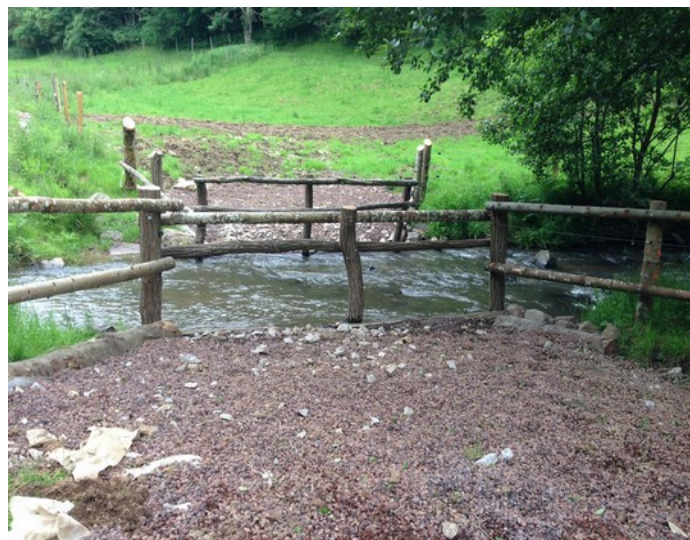
7: Abreuvoir terminé avec pouzzolane et clôture
