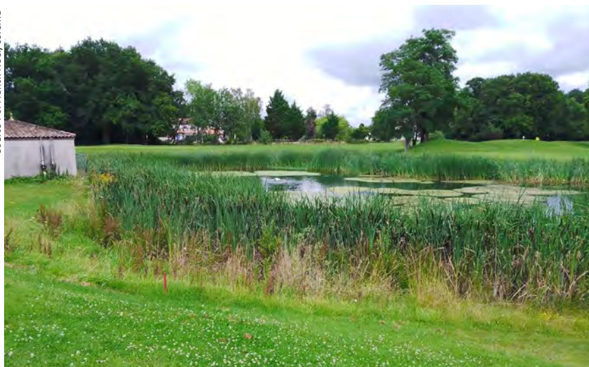
Illustration 15 - Lagune aérée et paysagée du golf de Saintes (100 m 3 ). L'eau issue de la STEU de Lormont (Boue activée, 40 000 EH) est filtrée avant son lagunage, puis désinfectée avant son utilisation pour l'arrosage du golf.
