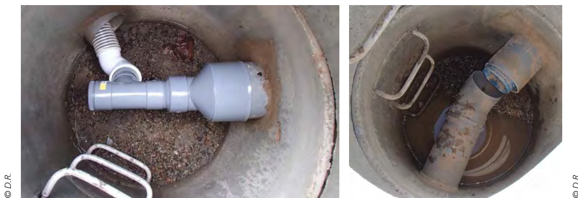
Figure 7. Connexion refaite dans le regard.
