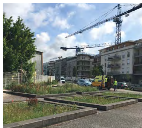
Figure 5 : Filtres à sable plantés.
