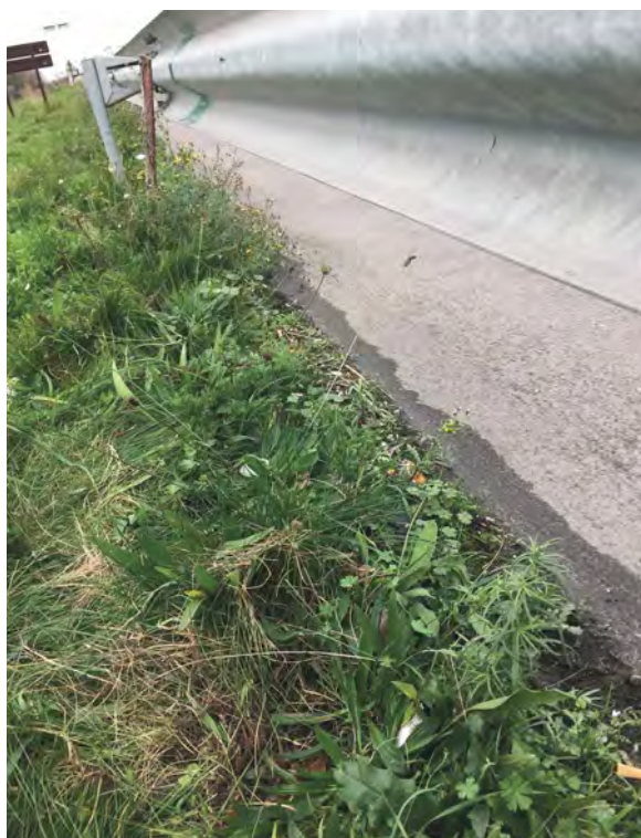
Figure 12. Le cumul de sédiment sur l'accotement à Compans.
