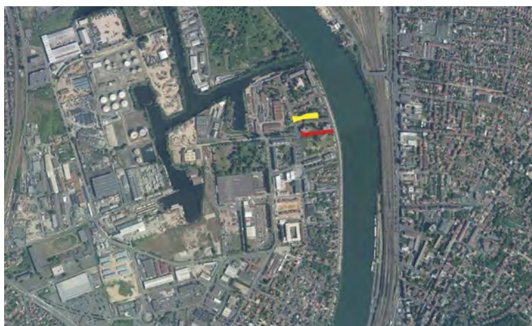
Figure 1. Vue aérienne de l'environnement du site d'étude à Villeneuve-le-Roi .
