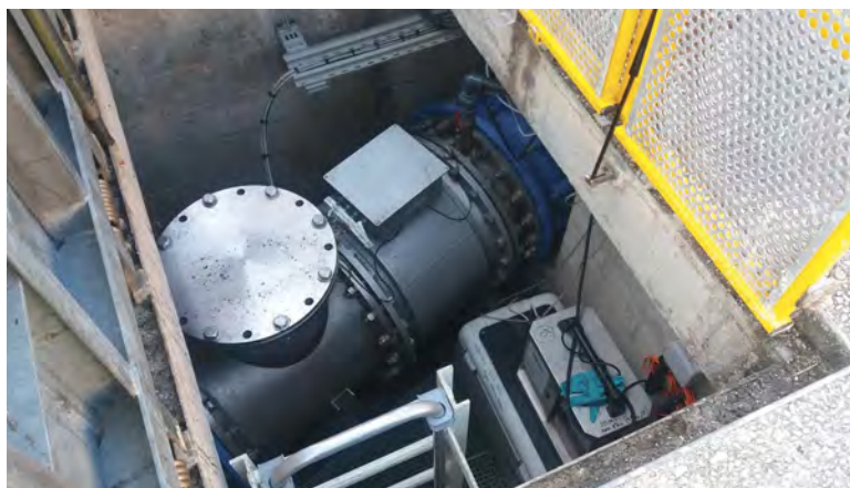
Figure 6. Débitmètre électromagnétique mesurant l'écoulement du ruissellement issu du bassin versant avec le dispositif de prélèvement d'eaux brutes.
