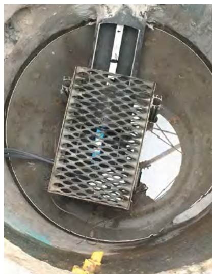
Figures 7 et 8. Obturateur déversoir employé pour mesurer le débit en sortie (aval des filtres et du vortex).
