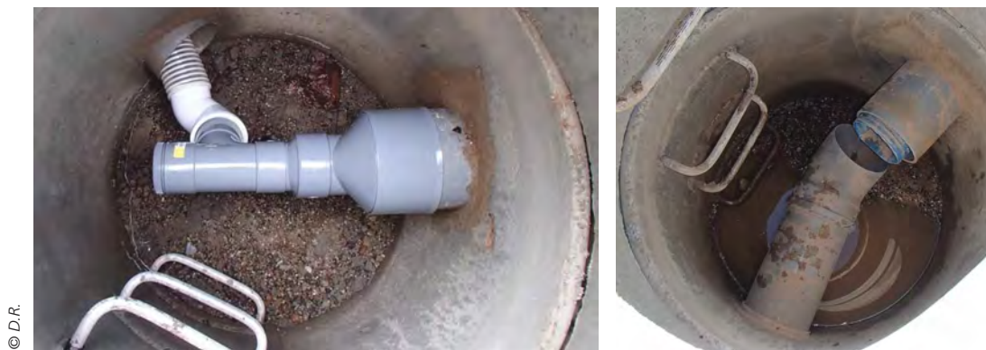
Figure 7. Connexion refaite dans le regard.
