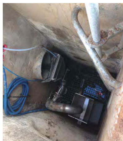
Figure 7. Siphon avec sonde Nivus en place dans le regard aval.
