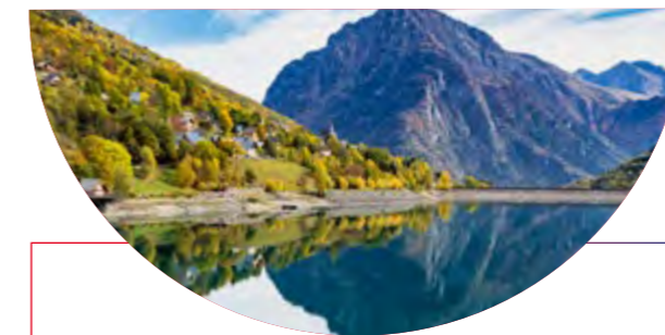
Isère, France : La STEP constituée des barrages de Grand'Maison et du Verney.
