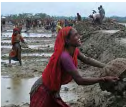
Construction d'une digue au Bangladesh.
